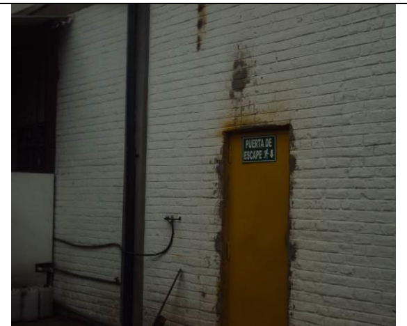
PUERTA DE ESCAPE
